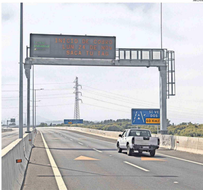
DESDE NOVIEMBRE DEL 2025 SE EFECTÚA COBRO POR PASAR POR EL PUENTE INDUSTRIAL.
