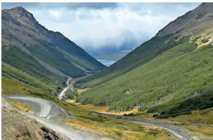
Uno de los tramos del camino Vicuña-Yendegaia ya construidos serpentea en las inmediaciones de la cordillera Darwin.
