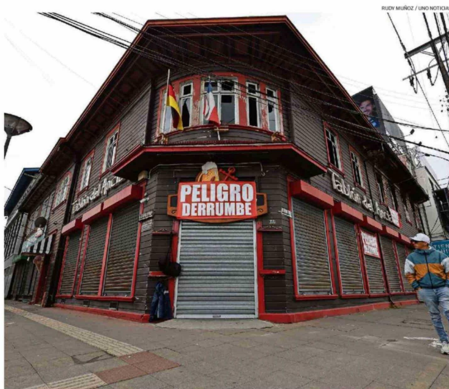
PROPIETARIOS DE RECINTOS INCENDIADOS EXIGEN CELERIDAD AL MINVU PARA EVITAR DERRUMBES EN EL CENTRO.
