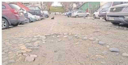
El tramo de calle Waldo Seguel cuyo deterioro del empedrado es evidente.
