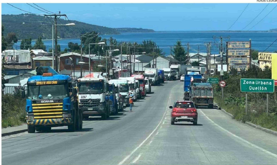
HASTA QUELLÓN LLEGARÁ UNA EVENTUAL CONCESIÓN DEL SEGUNDO TRAMO DE DOBLE VÍA EN LA PROVINCIA.
