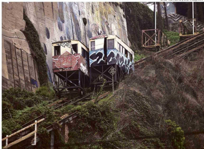
CONSULTORÍA SE ENFOCÓ EN EL SISTEMA ELECTROMECÁNICO Y EL PLANO DE RODADURA DE ARTILLERÍA.
