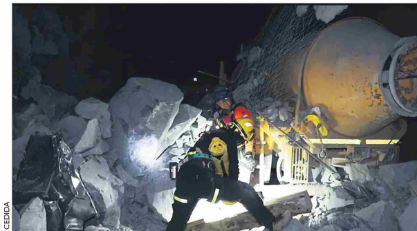
Funcionarios de la PDI y académicos ingresaron a la zona afectada.
