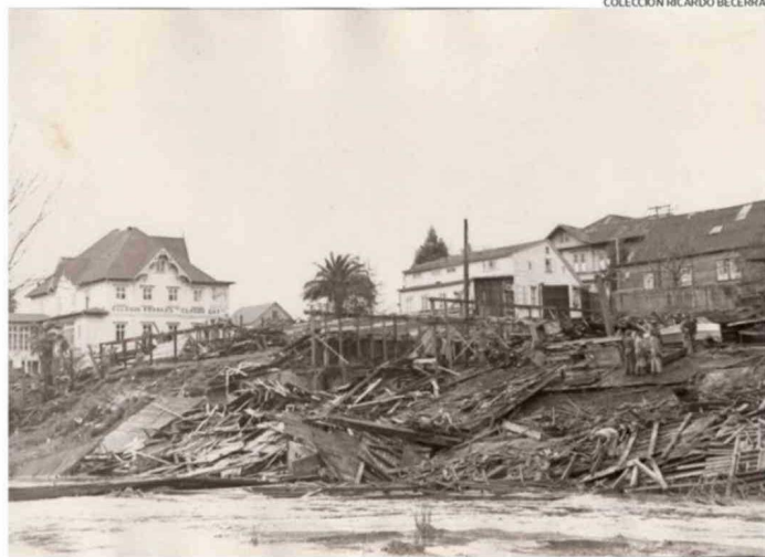
DAÑOS EN LA CIUDAD DE OSORNO, RIBERA DEL RÍO DAMÁS.
