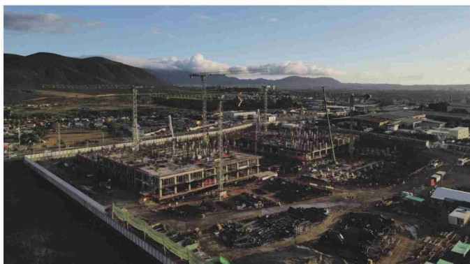
El nuevo Hospital de Coquimbo registra cerca de 130 mil metros cuadrados de construcción.
