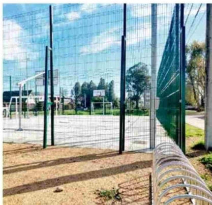
A feliz término llegó la construcción de infraestructura deportiva Villa Galilea Norponiente.
