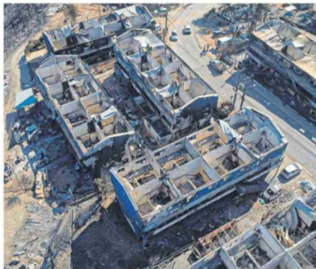
Blocks resultaron completamente destruidos en enero pasado.
