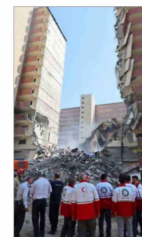
RESCATISTAS trabajan ayer en un edificio atacado por Israel.
