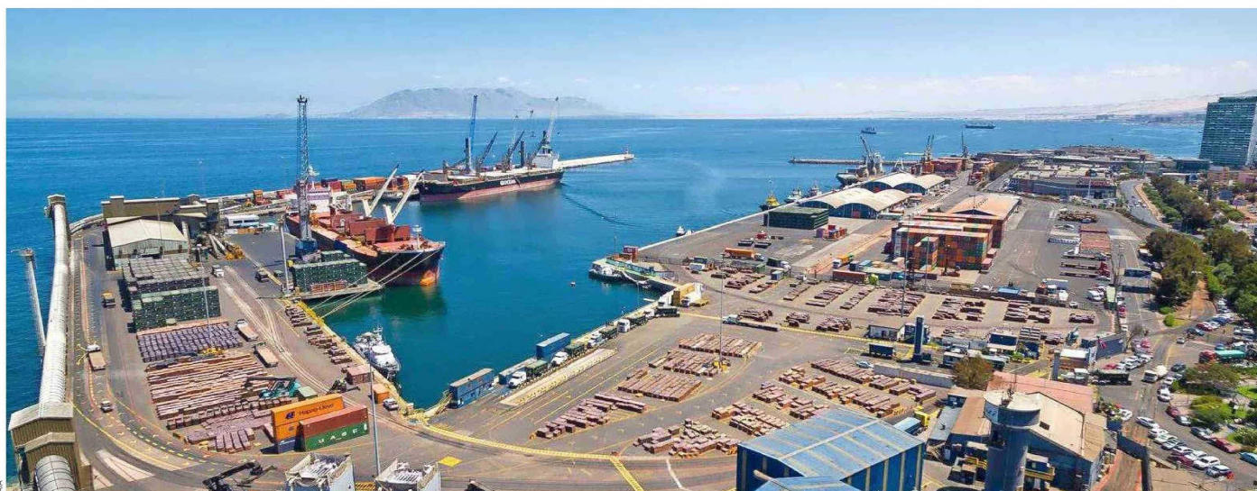
La infraestructura logística del norte de Chile permite la salida eficiente de minerales críticos hacia mercados internacionales.
