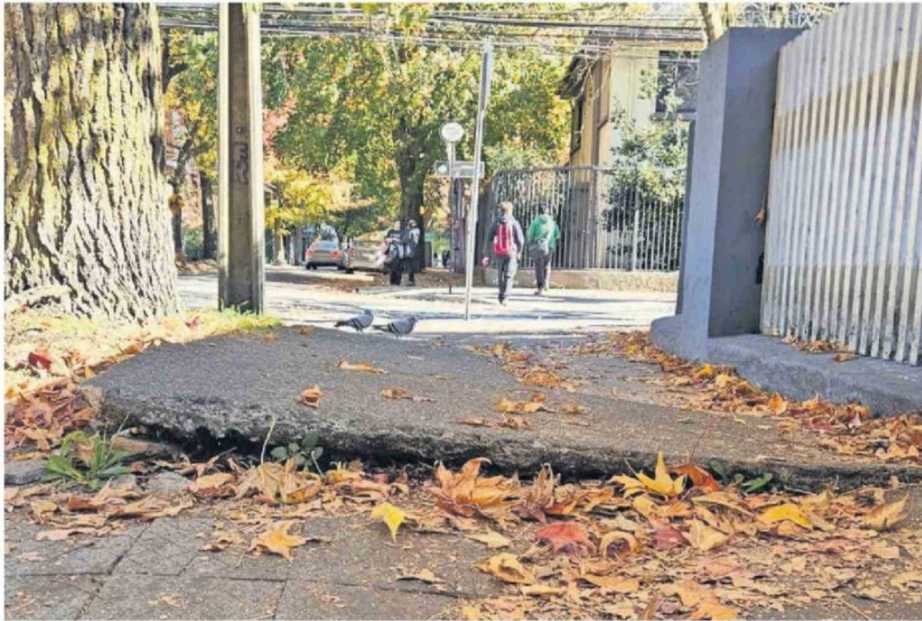
En la Junta de Vecinos Barrio Oriente dicen que el mal estado de las veredas entorpece la circulación de adultos mayores y coches de bebés.
