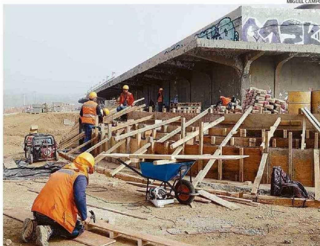
MÁS DE 200 TRABAJADORES ESTÁN DANDO FORMA AL PARQUE BARÓN EN SUS 12 HECTÁREAS DE TERRENO.
