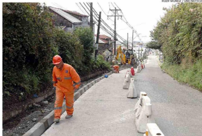
LOS TRABAJOS DE SERVIU EN LA CUESTA FEDERICO OELCKERS DEBERÍAN CONCLUIR EN UNAS DOS SEMANAS.
