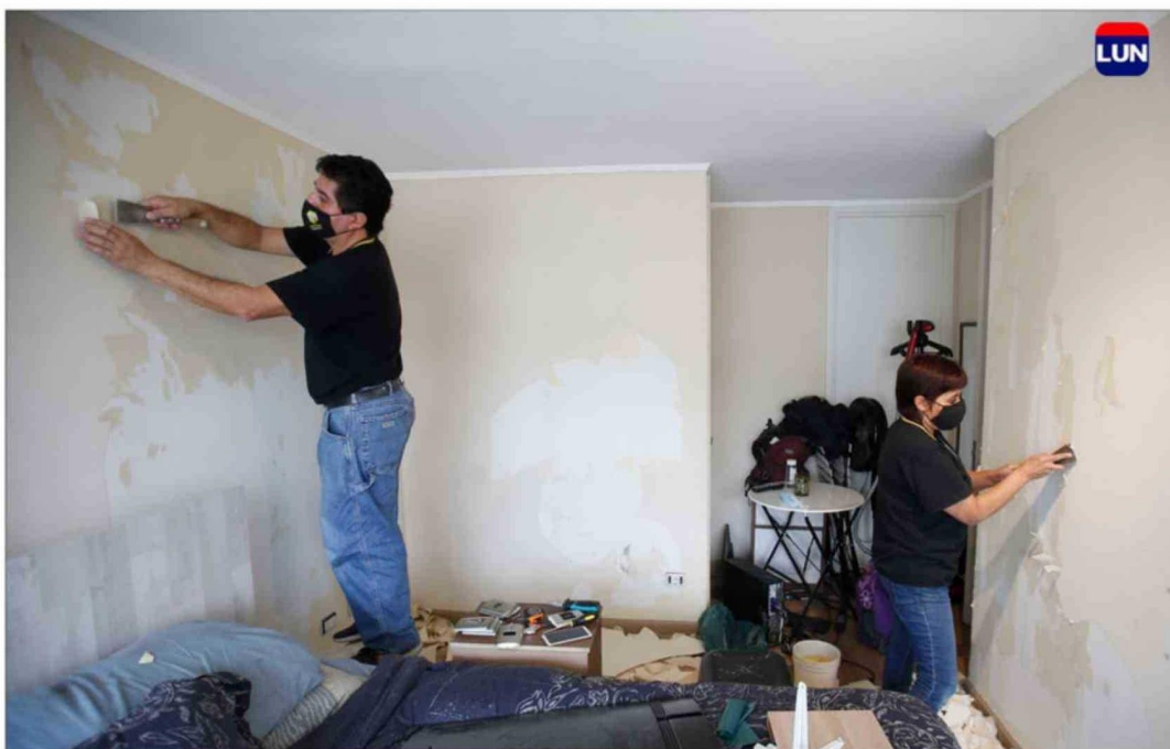
Obras que no intervienen mayormente el entorno, como ampliar una habitación o cambiar una fachada, se pueden acoger a este sistema.
