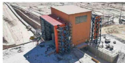
Entre las gestiones destaca la implementación de proyectos de infraestructura en las divisiones para el control de polvo
