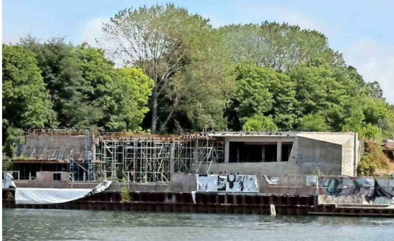
Obras paralizadas MAC Valdivia, febrero 2026.
