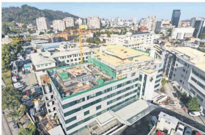
Las obras del helipuerto se llevan en paralelo y deberían estar listas en mayo.
