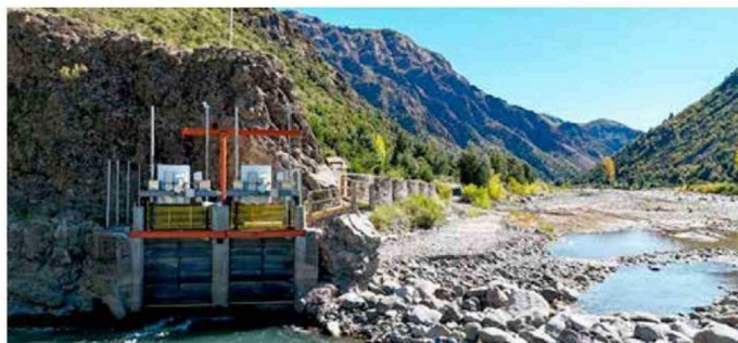
La inversión del Ministerio de OO.PP permitió la ejecución de los trabajos de conservación.
