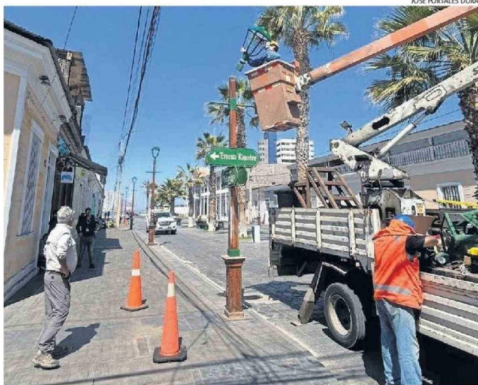
LOS TRABAJOS SE EXTENDERÁN DESDE LA PLAZA 21 DE MAYO HASTA LA PLAZA PRAT.
