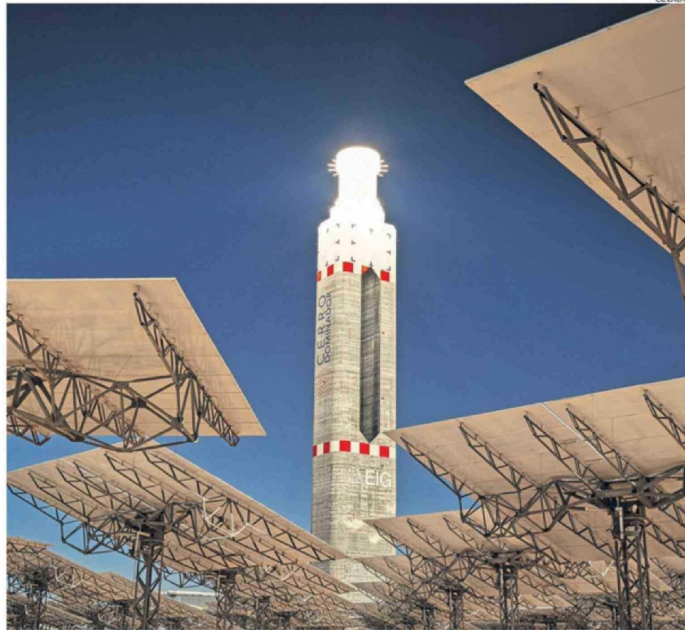
LA TORRE PRINCIPAL, DE CERRO DOMINADOR, DE 150 METROS, ES UNA DE LAS ESTRUCTURAS MAS ALTAS DEL PAÍS.
