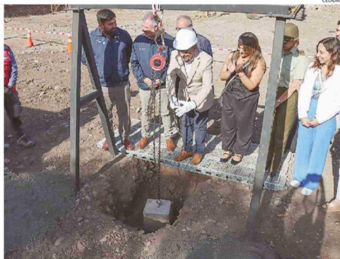
CON LA PRIMERA PIEDRA SE DAN INICIO A LAS OBRAS DE LA NUEVA COMISARÍA DE QUILLOTA.
