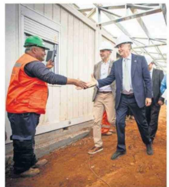
El Presidente revisó el avance de obras en Tomé.
