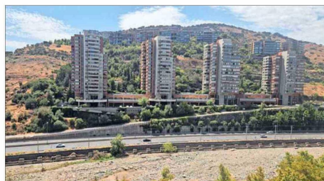
MEDIDAS. — Vecinos de la autopista piden la instalación de barreras para evitar los ruidos molestos de estos “piques”.
