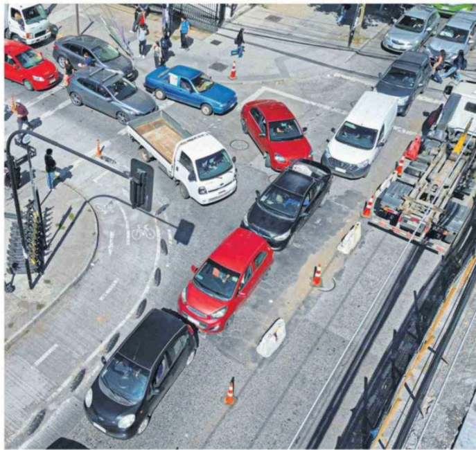
Una vez que finalicen las obras en el tramo intervenido, se cortará el tránsito en dirección a Collao.
