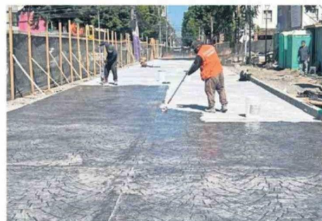
El viernes se aplicaron productos para sellar el pavimento.
