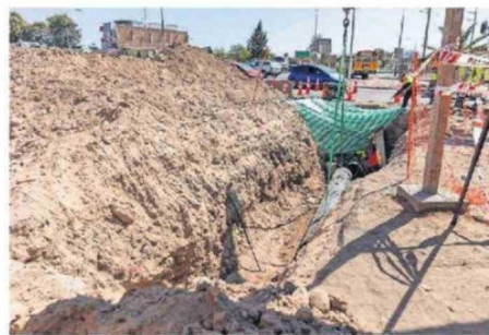
OBRAS AVANZAN RÁPIDAMENTE.
