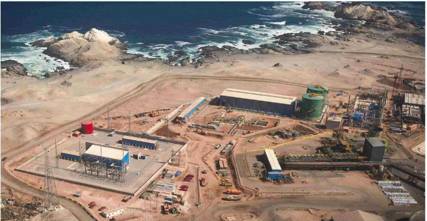
La estación de bombeo 1, ubicada en el Puerto de Collahuasi, fue la primera en ser energizada.
