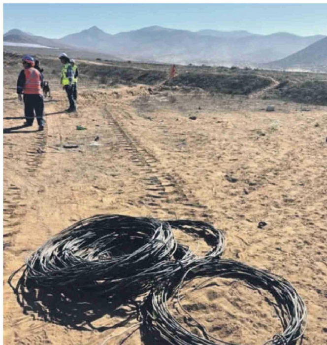
Este operativo permitió desmantelar, en diferentes puntos, conexiones eléctricas irregulares en los asentamientos del sector de La Varilla.
