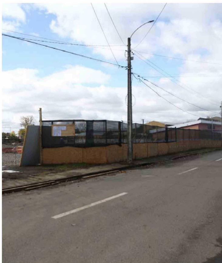
En Chillán Viejo ya se observa movimiento de tierras en el predio donde se proyectaría un local de Superbodega aCuenta.
