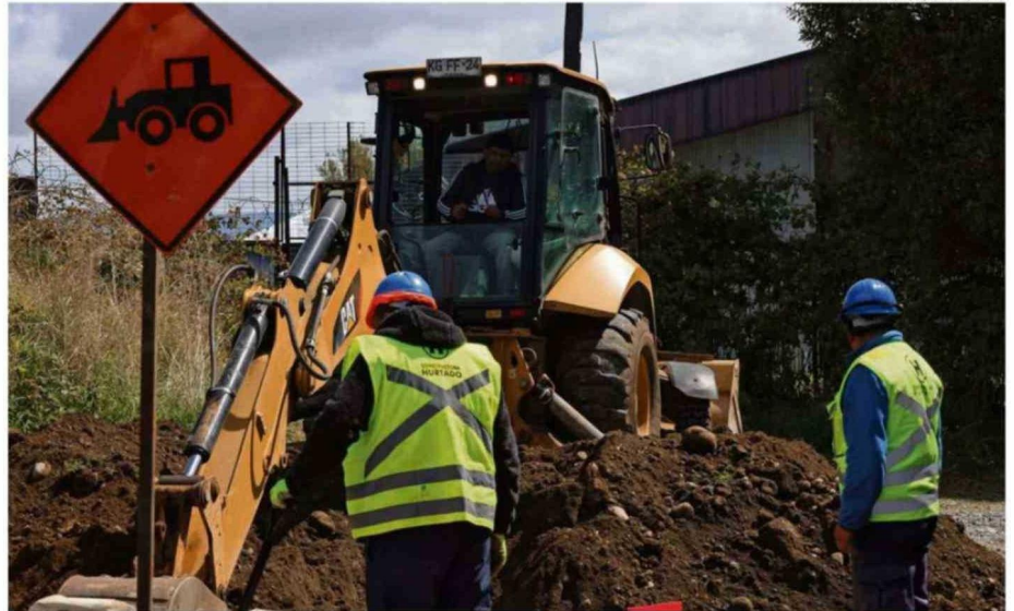
LAS FAENAS INVOLUCRAN EL DESPLIEGUE DE AL MENOS 20 TRABAJADORES Y MAQUINARIA PESADA PARA TRANSFORMAR VÍAS DE RIPIO A HORMIGÓN.
