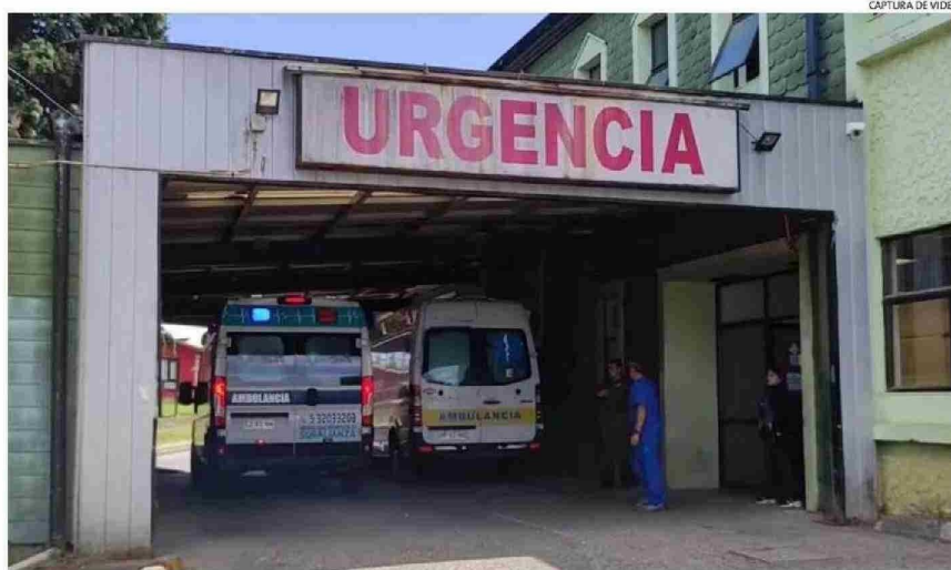
EN EL HOSPITAL DE ANCIUD ESTÁ TRABAJANDO UNA EMPRESAS ENCARGADA DEL MANTENIMIENTO PARA RESOLVER EL PROBLEMA.
