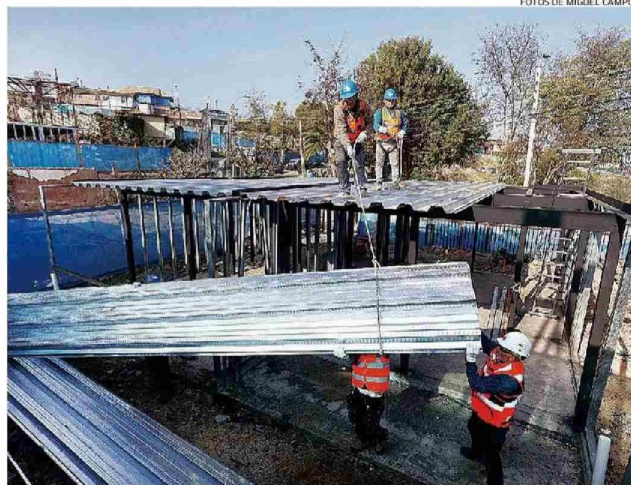
170 VIVIENDAS SERÁN DESMANTELADAS, INCLUYENDO 56 QUE PRESENTAN MÁS DE UN 90% DE AVANCE.
