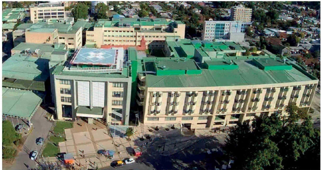
INFORMES DE LA CONTRALORÍA revelaron la existencia de irregularidades en distintos ámbitos, al interior del Complejo Asistencial "Dr. Víctor Ríos Ruiz" de Los Angeles.
