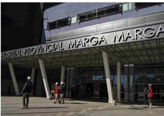
Hospital Provincial Marga Marga entra en tierra derecha: este jueves será entregado administrativamente al Servicio de Salud
