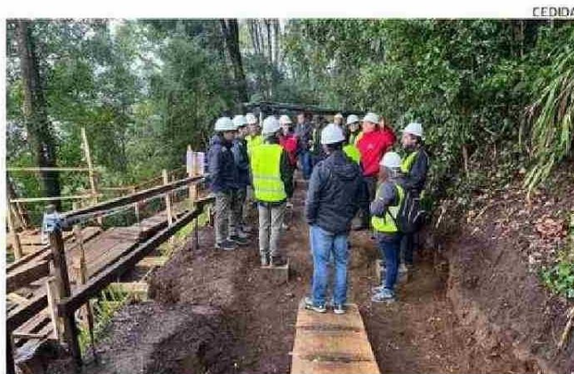
CORES Y EL ALCALDE GÁRATE REVISARON EL AVANCE DE ESOS TRABAJOS.
