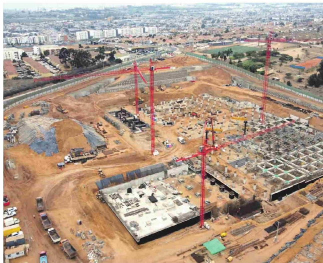
En La Serena, las obras del hospital ya presentan un avance del 6%.
