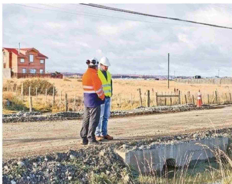
Con el término de las faenas ejecutadas por la Dirección Regional de Vialidad en parte del sector Huertos Familiares de Puerto Natales, personeros de gobierno realizaron una inspección en terreno
