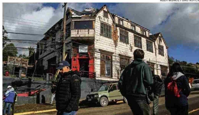
EL RESTO BAR “EL CIUDADANO 587” DE CALLE DEL SALVADOR, SE VIO AFECTADO EN SU INFRAESTRUCTURA.
