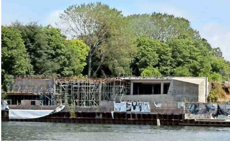
Obras paralizadas MAC Valdivia, febrero 2026.
