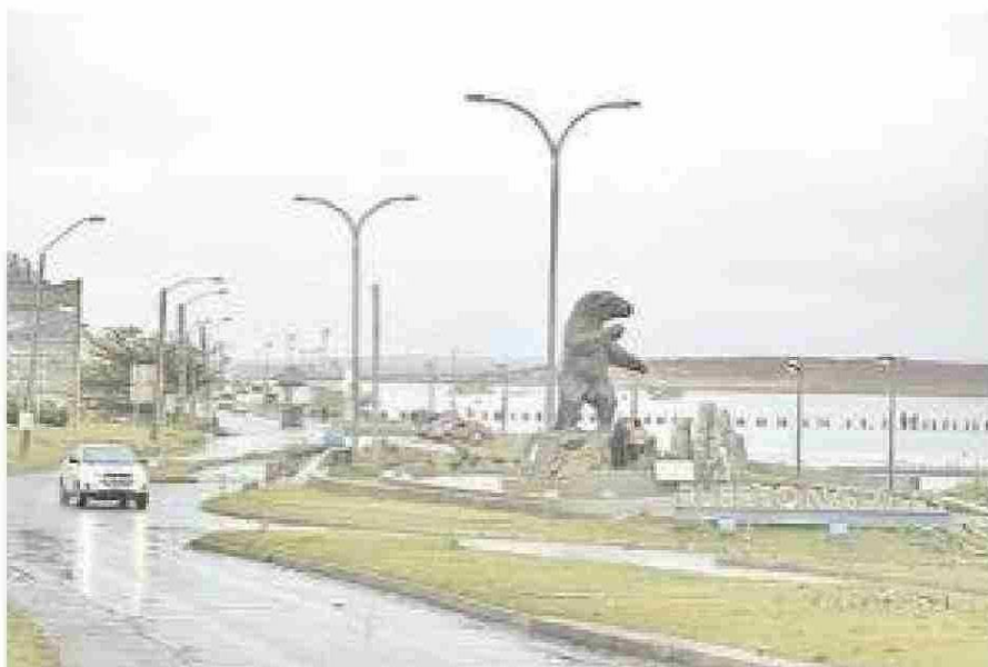
En 2027 se podría inaugurar el nuevo tramo de la costanera Pedro Montt de Natales.
