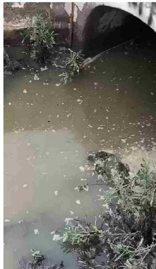
En las imágenes difundidas por los denunciantes se puede apreciar como se vertieron las aguas servidas al río Elqui.
