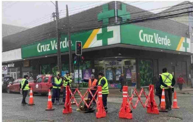
VIALIDAD LLAMÓ A LA COMPRENSIÓN DE LOS USUARIOS.
