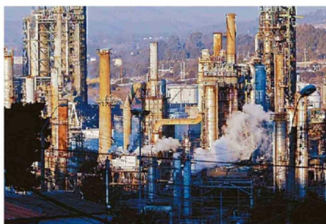
IRREGULARIDADES AFECTAN A LA REFINERÍA ACONCAGUA, EN CONCÓN.
