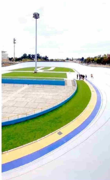
Según el IND, lo que hay en la pista son microfisuras que no representan riesgo técnico ni afectan el rodado de las bicicletas.
