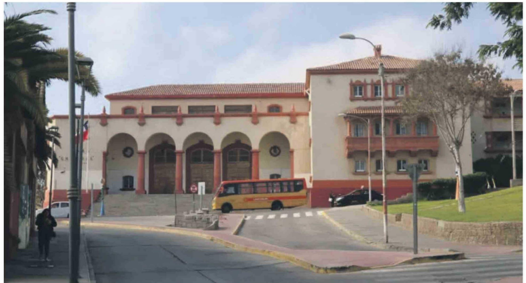
Filtraciones, daños estructurales y espacios clausurados forman parte de las problemáticas denunciadas en el Liceo Gabriela Mistral, situaciones que, por cierto, se repiten en buena parte de las escuelas y liceos públicos de La Serena.
