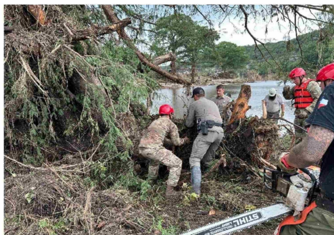
► Rescatistas de Seguridad Pública de Texas revisan los escombros y los daños.
