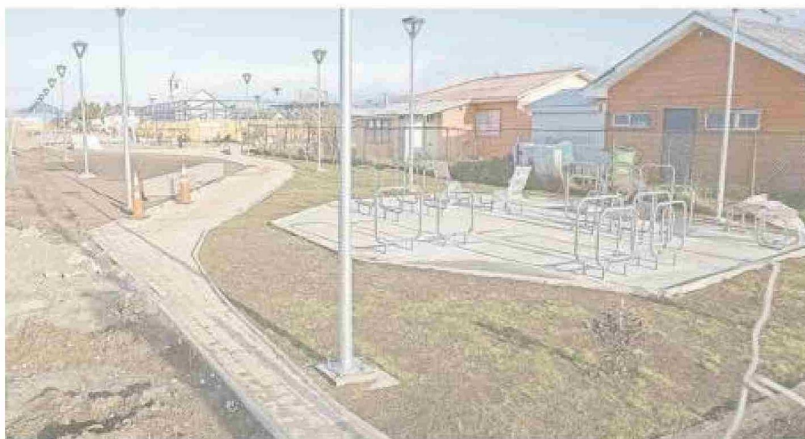
El nuevo parque se construye sobre el estero Llau Llau, en villa Las Nieves.
