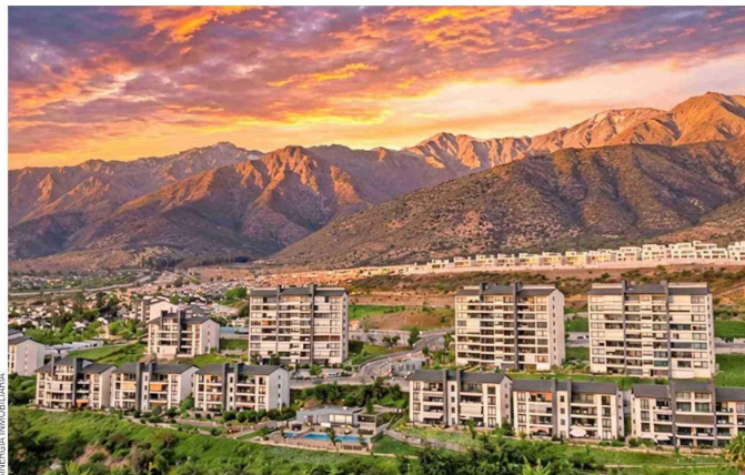
El proyecto habitacional Alto Macul, en la comuna de La Florida, es una de las transformaciones urbanas más relevantes de Santiago en las últimas décadas.
